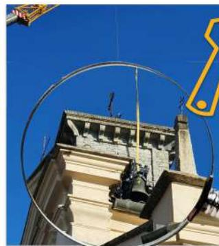
Per la rimozione e la posa in opera delle due campane si è ricorsi ad un'autogru con braccio da 70 metri.
